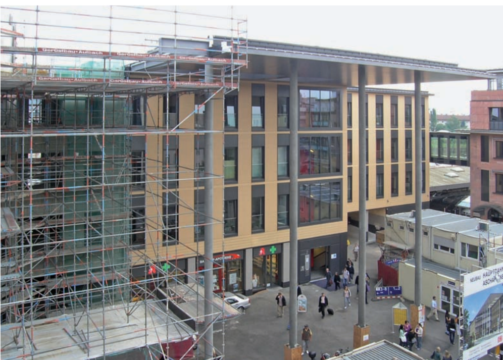
BEREITS FERTIGGESTELLT – der erste Bauabschnitt des neuen Hauptbahnhofs
