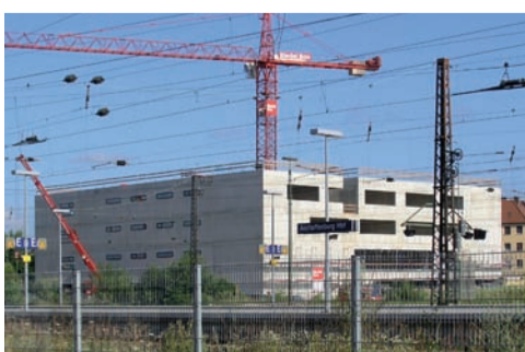
DER ROHBAU IST FAST FERTIG – Die neue FOS/BOS
