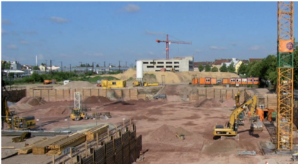
ASCHAFFENBURGS GRÖSSTE BAUGRUBE: Blick zum Dämmer Steg mit Neubau Fachoberschule
