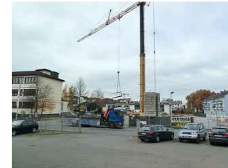
Baustelle für Wohnungsneubau in der Bernhardstraße/Ecke Schneidmühlweg.
