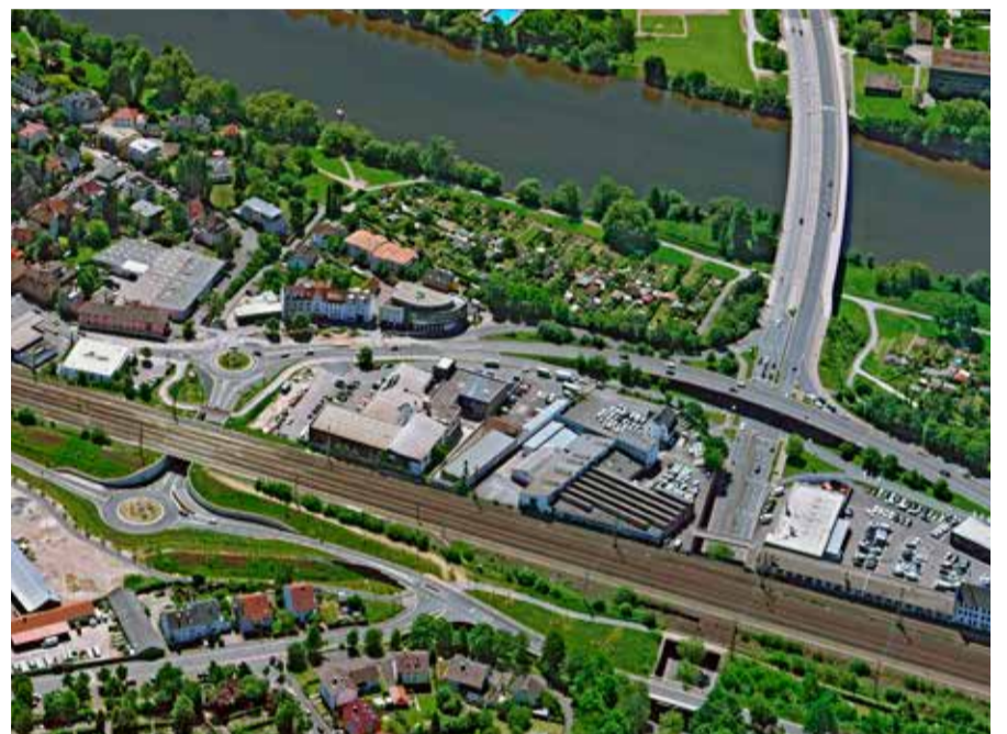
Mit den neuen Knotenpunkten und der Eisenbahnunterführung zwischen Hanauer Straße und Schönbergweg wurde ein neuer attraktiver Fuß- und Radweg realisiert. Ein Erdwall an der Linkstraße bildet einen wirksamen Lärmschutz. An den beiden neuen Kreisverkehrsplätzen sorgen zusätzliche Fahrspuren (Bypässe) für einen reibungslosen Verkehrsablauf. (dk)
