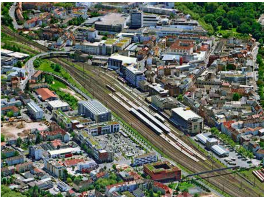
Auf dem ehemaligen Rangierbahnhof ist ein lebendiges neues Stadtviertel entstanden. Die Bahnparallele erschließt das Gebiet Bahnhof Nord mit der Bert-Brecht-Straße und der Heinrich-Böll-Straße. Fotos: Hajo Dietz Luftbildfotografie
