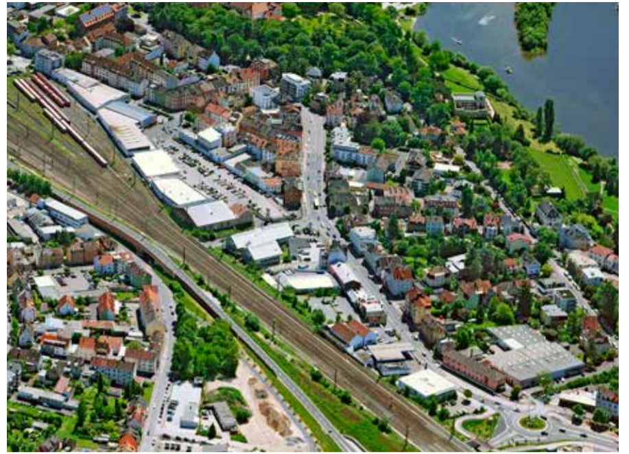
Die Bahnparallele übernimmt die Funktion des Nordrings. Hiermit wird die Schillerstraße vom Durchgangsverkehr entlastet. Mit der Bahnparallele wurde eine neue Brücke an der Burchhardstraße gebaut. Lärmschutzwände schützen die angrenzende Wohnbebauung vor Verkehrslärm.
