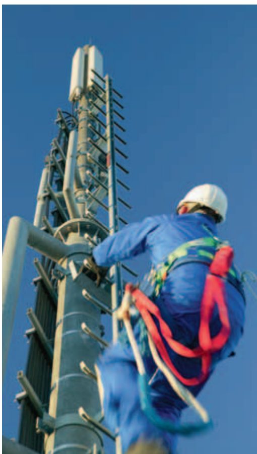
Eine UMTS-Antenne – auch in Aschaffenburg wird das UMTS-Netz, die dritte Mobilfunkgeneration, derzeit ausgebaut. Foto: Copyright O2
