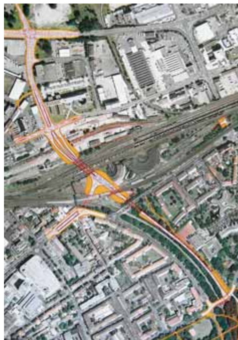
Die Arbeiten am Ringschluss Ost laufen auf Hochtouren.
