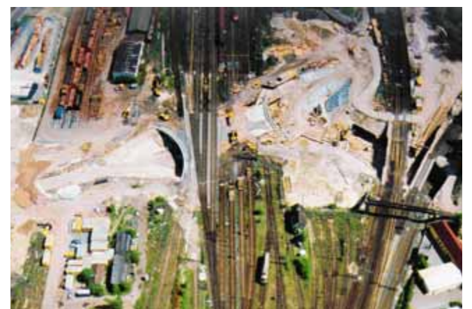
Am 22. Juli konnten die Bürger der Stadt Aschaffenburg die Baustelle Ringschluss Ost (Bahnquerung) besichtigen. Oberbürgermeister Klaus Herzog erläuterte die Baumaßnahmen.
