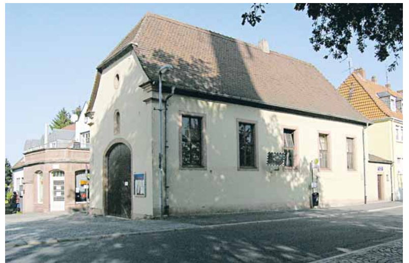
Die Michaelskapelle in Damm hat eine bewegte Geschichte. Zeitweise als Feuerwehrhaus genutzt, wird sie nun zu einem "Haus der Vereine" mit multifunktionalem Veranstaltungsraum umgebaut.
