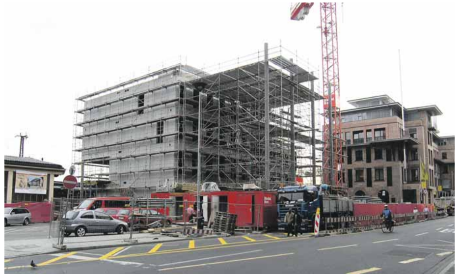
Östlich der alten Empfangshalle reicht der Rohbau des neuen Hauptbahnhofs bereits bis in den dritten Stock.
