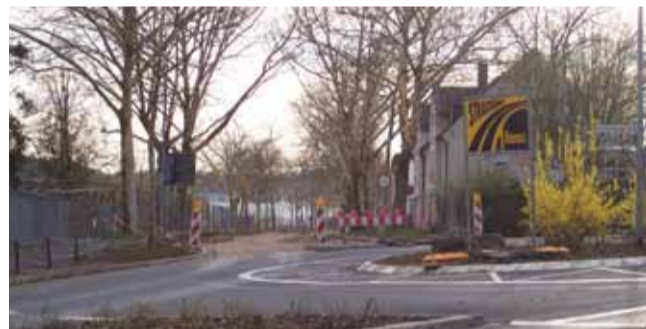
In der ersten Bauphase wird der Straßenabschnitt zwischen Schweinheimer Kreisel und Alois-Grimm-Straße saniert.
