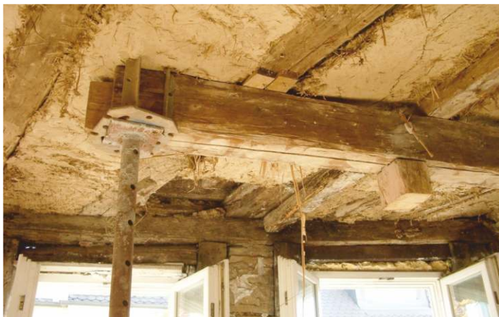
Sanierungsbedürftige Fehlbodendecke mit Lehmputz
