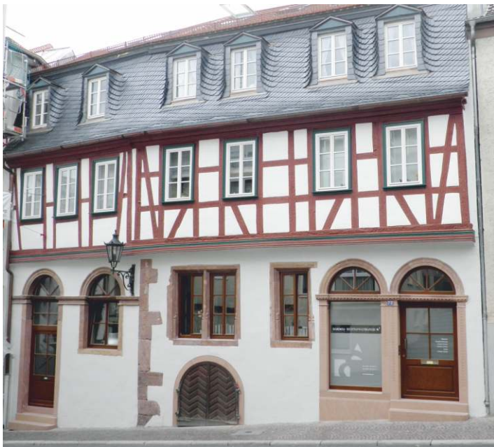
Straßenfassade nach der Sanierung
