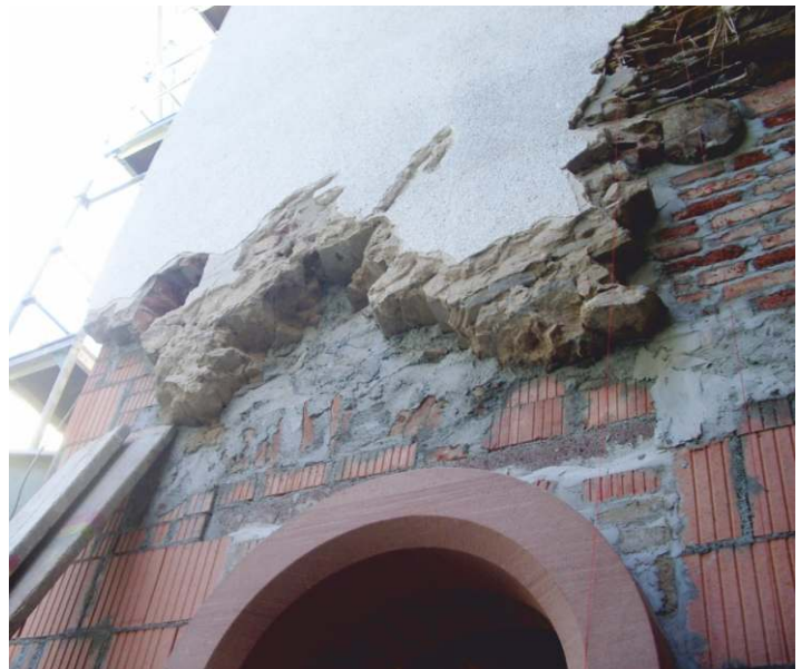
Ertüchtigung der nicht mehr tragfähigen, rückseitigen Außenwand
