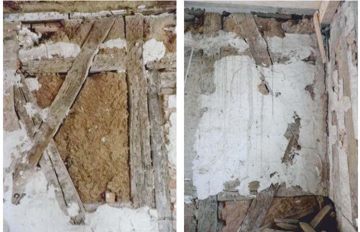
Fachwerk-Strebefiguren an den Bund- und Eckstielen der ehemaligen Außenwand
