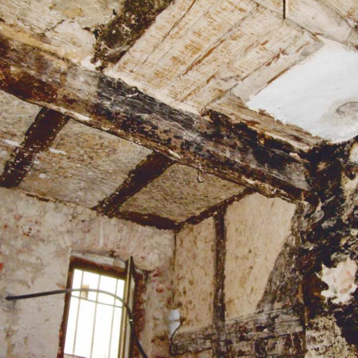
Jahrhunderte alte Balkenstrukturen im Kernbau des 16. Jh.
