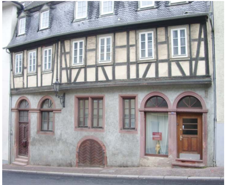
Straßenfassade vor der Sanierung im Herbst 2010
