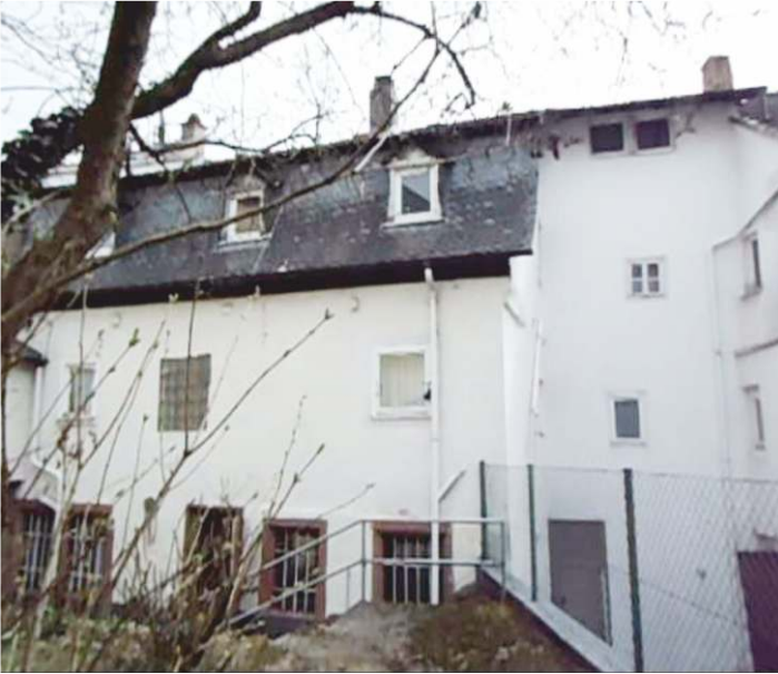
Rückseite vor der Sanierung im Herbst 2010
