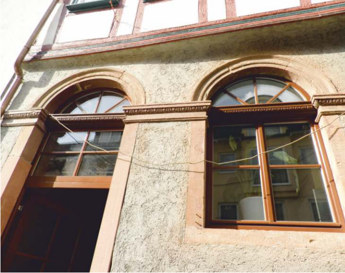
Fenster und Türe mit Rundbogen und Kämpfergesims aus dem 19. Jahrhundert
