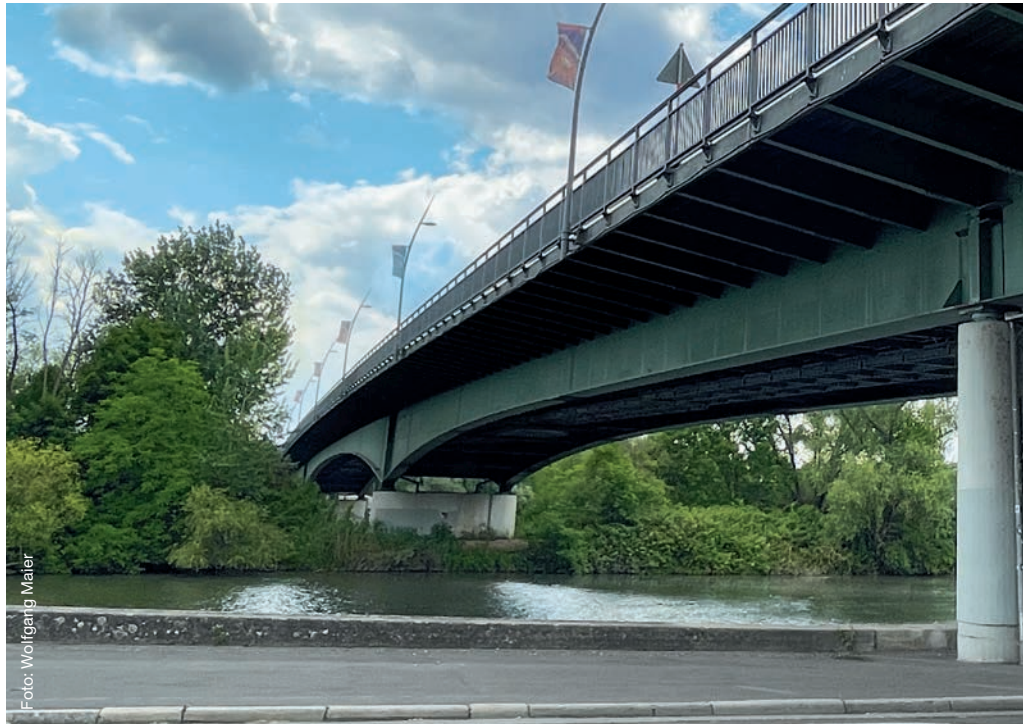
Die runderneuerte Willigisbrücke wurde im Mai 2023 fristgerecht fertiggestellt.
