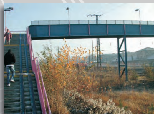
Dicht am Treppenaufgang verläuft die Bahnparallele unter dem Dammer Steg hindurch.
