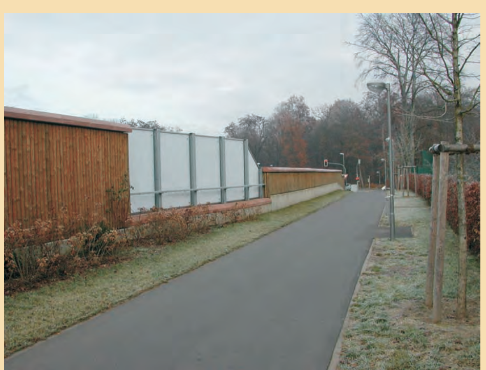
Lärmschutz für die Anwohner: So wie hier an der Ringstraße sind auch entlang der Bahnparallele Lärmschutzwände vorgesehen
