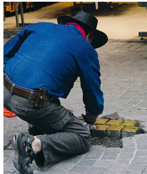
Sorgsam fügt der Kölner Künstler Gunter Demnig die Stolpersteine für die Familie Wolfsthal ins Pflaster der Herstattstraße.
