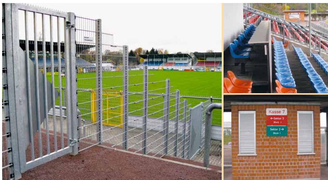
Durch einen Zaun unterteilte Blocks, Arbeitsplätze für die Pressevertreter und eine klare Beschilderung an den Kassenhäuschen – das Stadion Schönbusch wird künftig den Auflagen des DFB gerecht.
