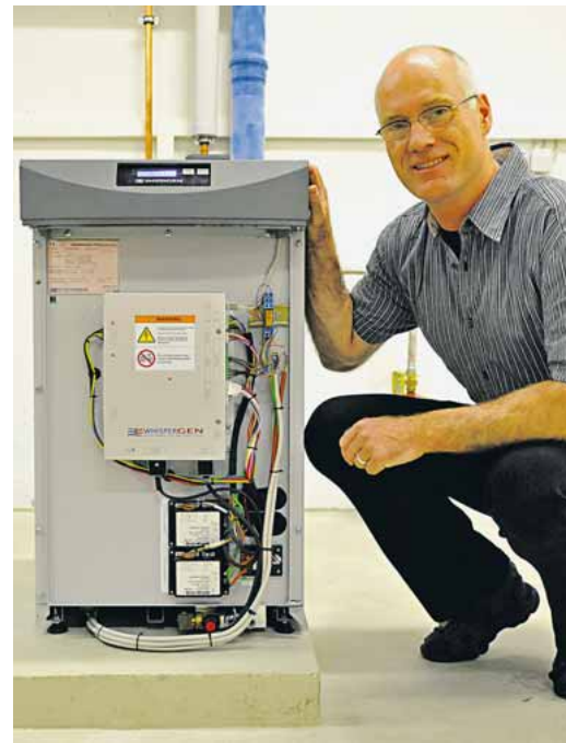
Bruno Mantel ist bei der Aschaffener Versorgungs GmbH der Experte für Heiztechnik.
