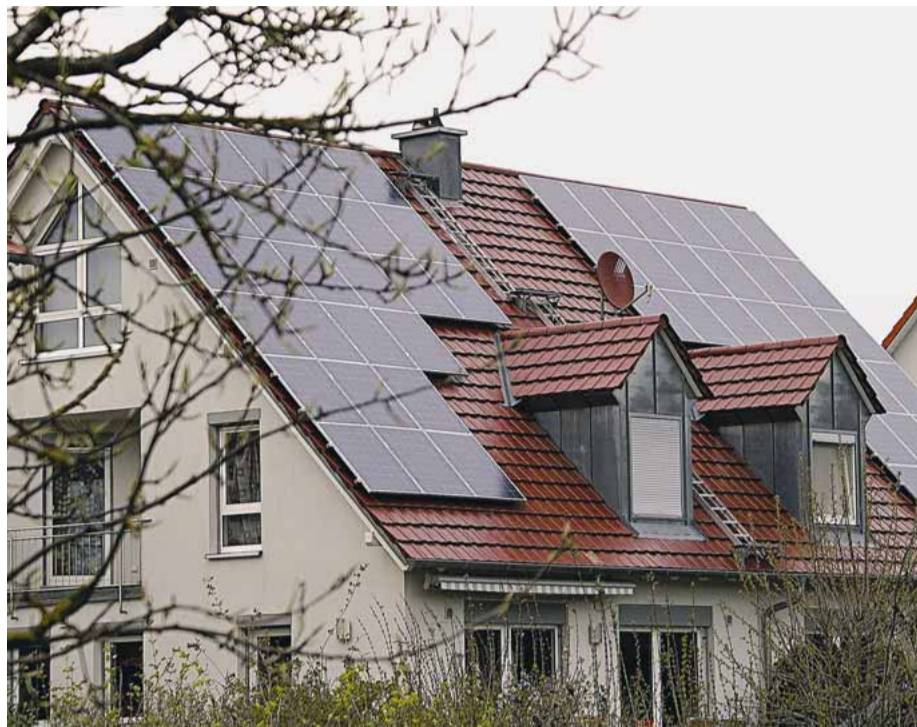
Gerade bei großen Dachflächen in Südlage lohnt sich die Installation von Fotovoltaikanlagen wirtschaftlich und ökologisch.
