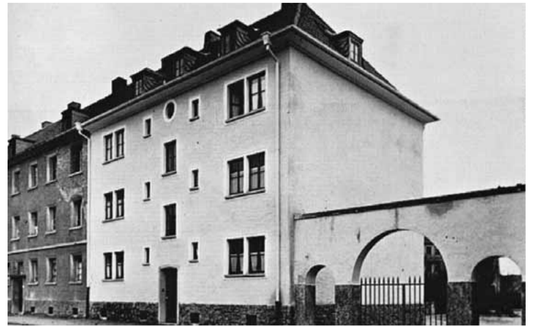
Kurz nach Kriegsende begann die Stadtbau Aschaffenburg mit der Renovierung der Häuser in der Schillerstraße 13...
