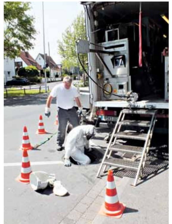
Sanierung in geschlossener Bauweise – modernste Technik ist bei der Kanalsanierung im Einsatz.
