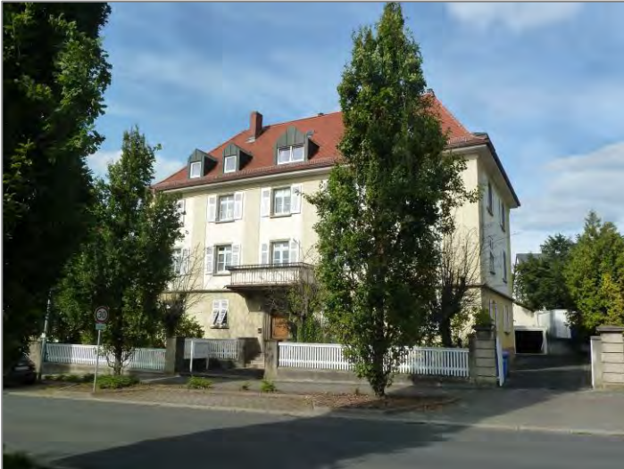
Ludwigsallee 17: III Geschosse plus ausgebautes Walmdach
