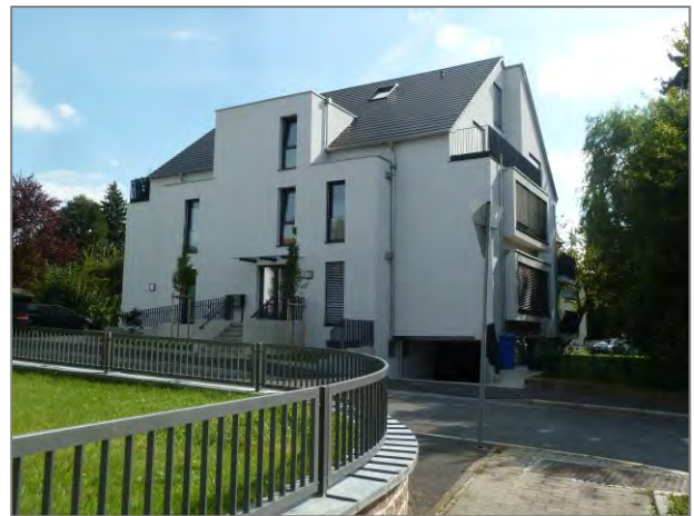
Neubau eines Mehrfamilienhauses (5 WE) mit Tiefgarage in der Steinstraße 2
