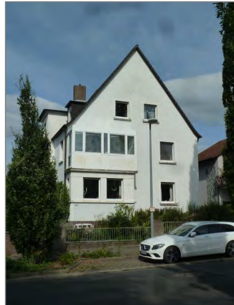
Ludwigsallee 25: Sockel, zwei Regelgeschosse, steiles ausgebautes Satteldach
