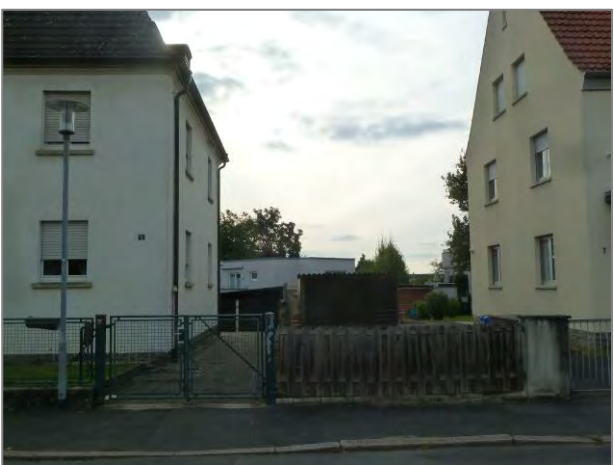
Innenliegendes Einfamilienhaus Steinstraße 16a (im Hintergrund)
