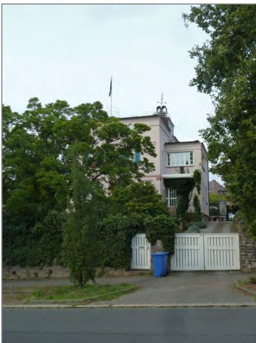
Weit von der Straße abgerückt: Ludwigsallee 31
