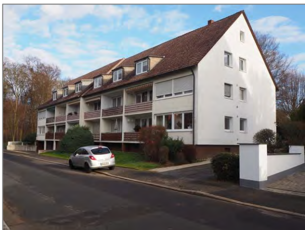
Großes Mehrfamilienhaus Scharnhorststr. 22-24
