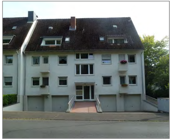
Bismarckallee 38 mit breiter Garagenfront im Untergeschoss
