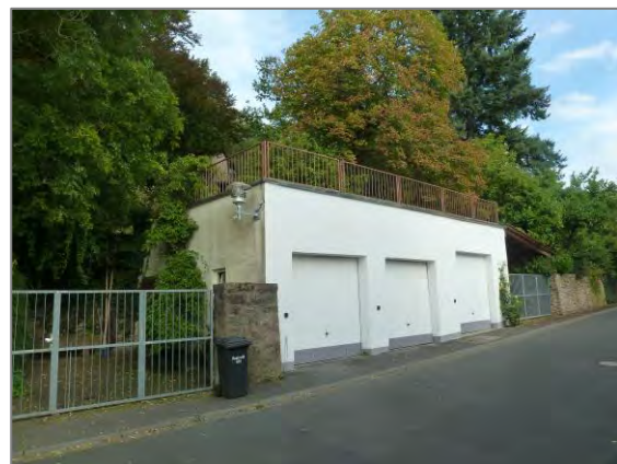
Unmittelbar an der Straße Lug ins Land errichteter Garagentrakt auf dem Grundstück Lug ins Land 9
