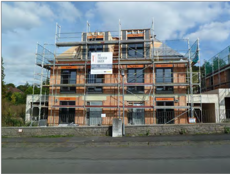
Neubau eines Doppelhauses in der Gneisenastr. 6
