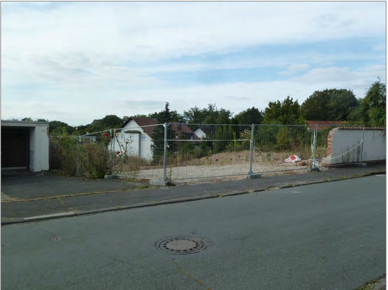
Baustelle für ein Einfamilienhaus in der Yorckstraße 33
