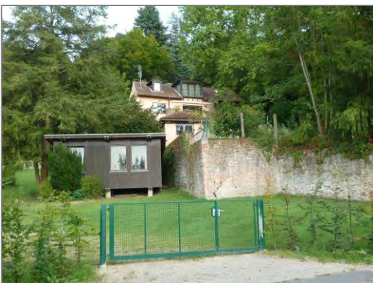
Im hinteren Grundstücksteil stehendes Wohnhaus Lug ins Land 9
