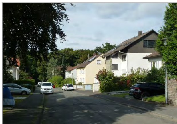
Die Gneisenaustraße (Blick nach Norden) mit ihrer Bebauung auf der Ostseite
