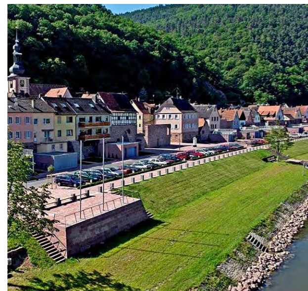
Der Hochwasserschutz in Freudenberg am Main kann mit mobilen Elementen erweitert werden
