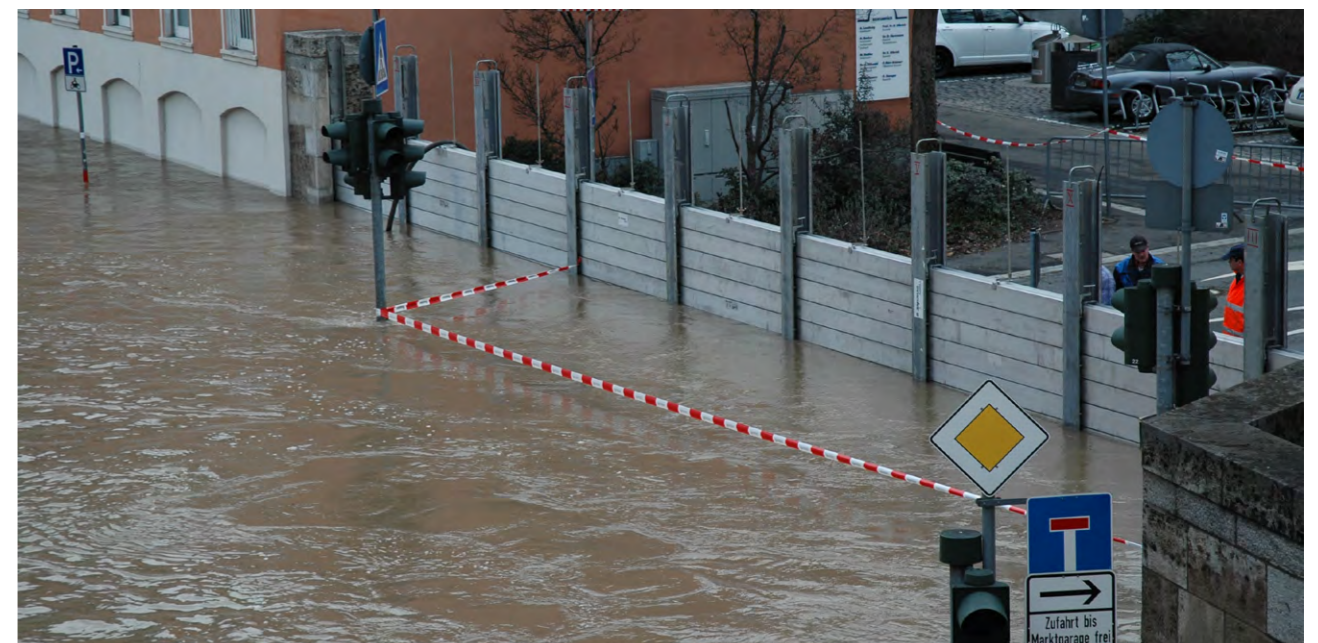
Die Hochwassermauer in Würzburg schützt dahinterliegende Gebäude bis zu einem 100-jährlichen Ereignis
