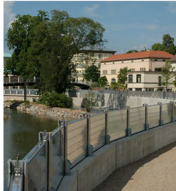
Hochwasserschutzmauer an der Fränkischen Saale in Bad Kissingen
