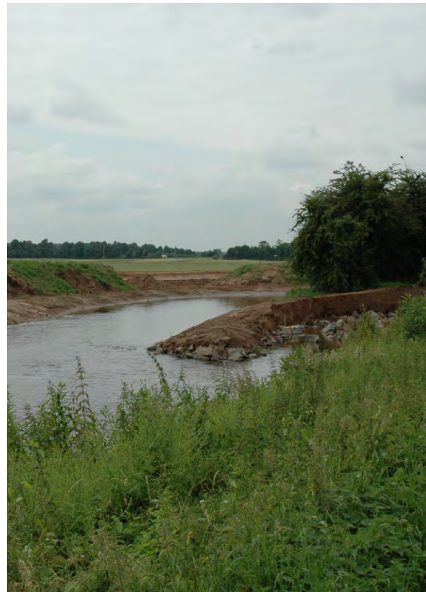
Die Kahl bei Alzenau während der Bauphase
