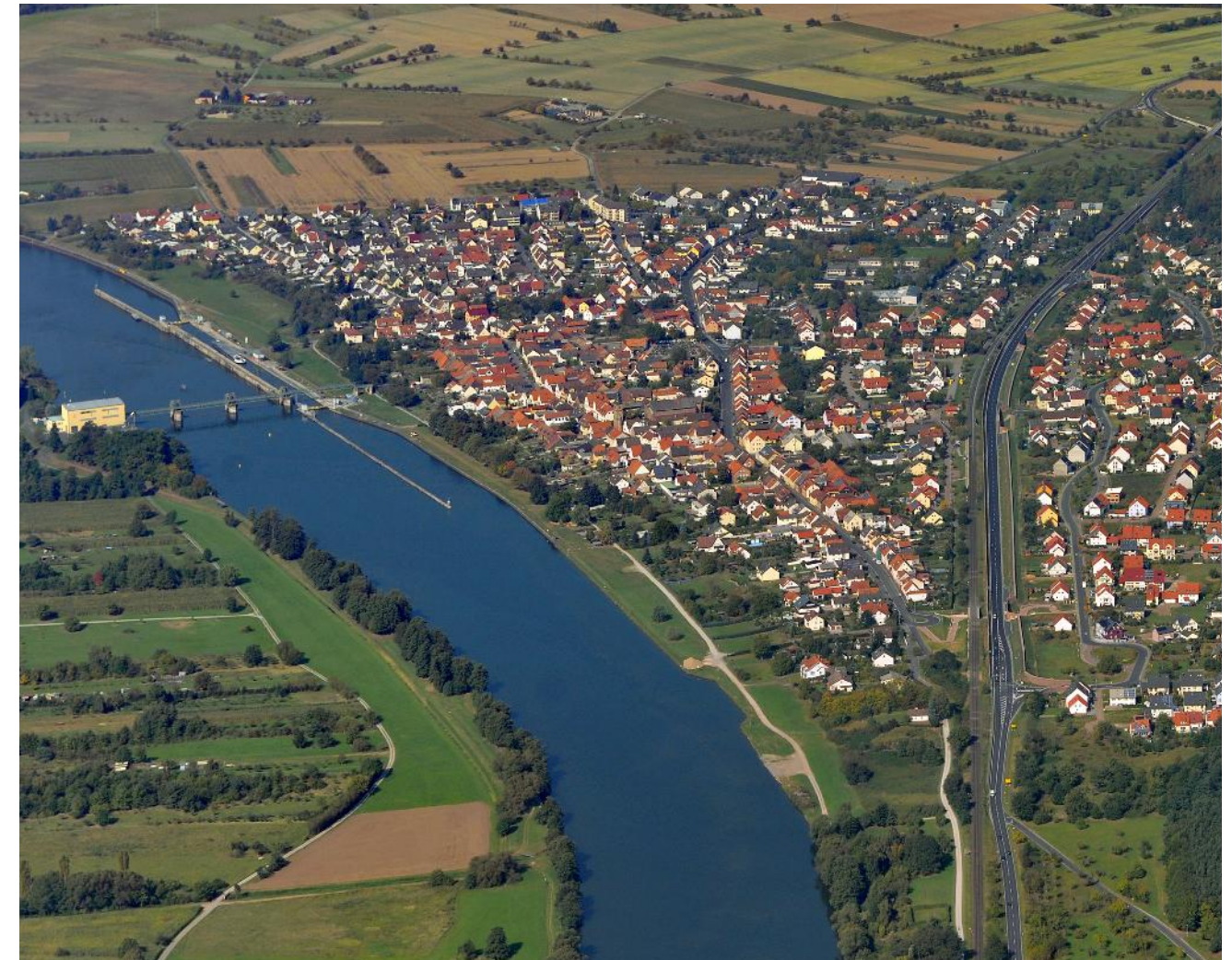
Schrägluftfoto Obernau. Blickrichtung Nordwesten.
