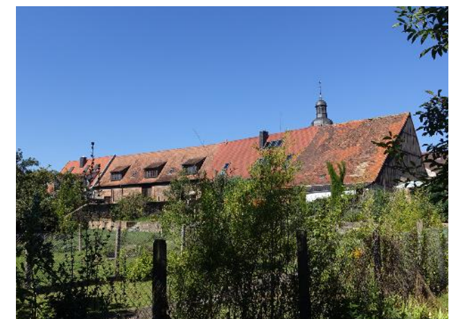
Ortstypischer Scheunenkrans mit „Maingärten“
