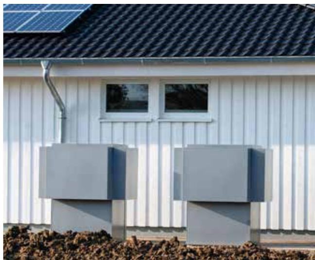
Große Wärmetauscher für Luft-Wasser-Wärmepumpen / Foto © Viessmann
