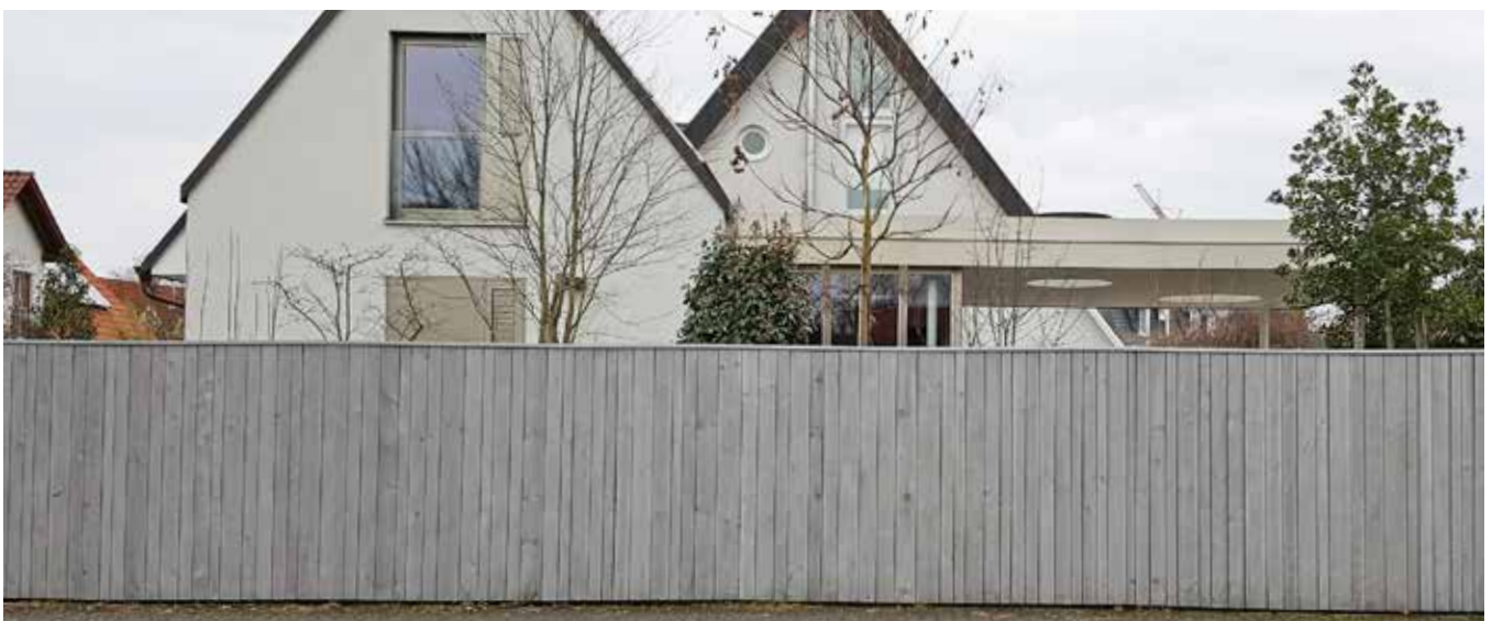
Einfriedung als ergänzender Lärmschutz / Aschaffenburg / Foto © Stadtplanungsamt AB
