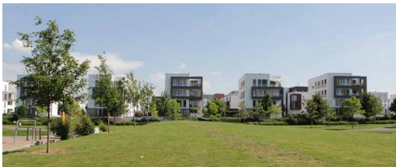
Mehrfamilienhäuser am Park / Frankfurt a.M. / Foto © planquadrat
