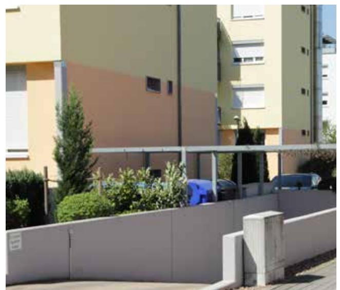
Tiefgarageneinfahrt MFH / Aschaffenburg / Foto © planquadrat
