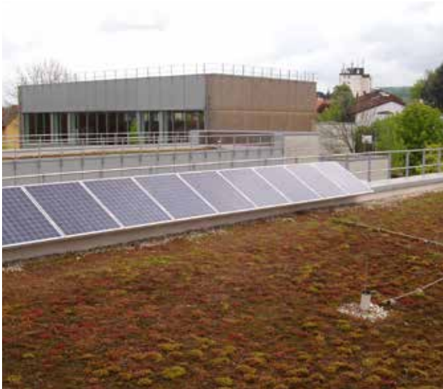
Pavillon-1 der Hefner-Alteneck-Schule / Foto © Reidl
