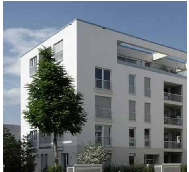
Mehrfamilienhaus / Frankfurt a.M. / Foto © planquadrat
