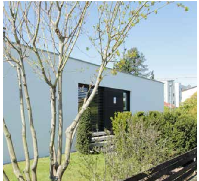
Einfamilienhaus / Aschaffenburg / Foto © planquadrat
