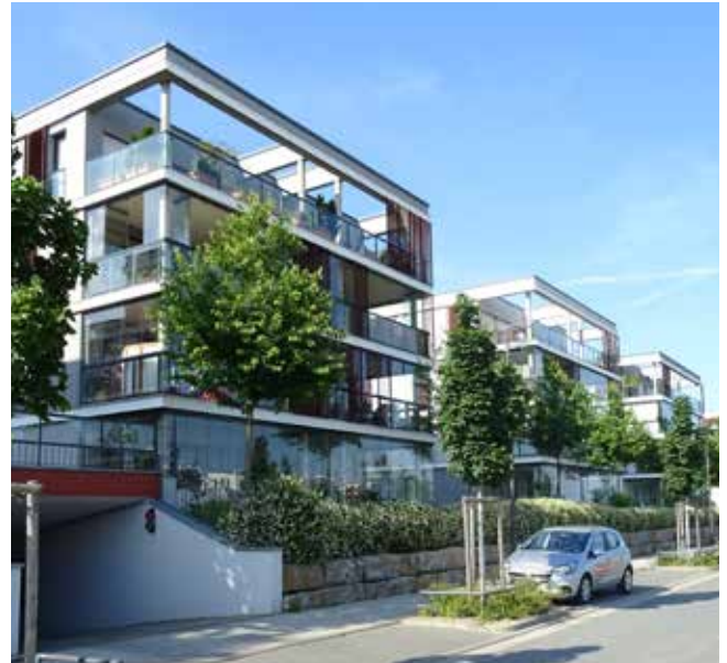
Mehrfamilienhäuser / Frankfurt a.M. / Foto © planquadrat
