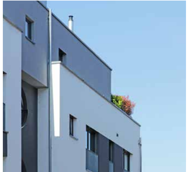
Oberstes Geschoss eines MFH / Aschaffenburg / Foto © planquadrat
