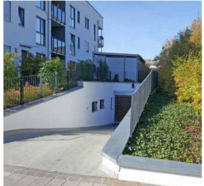
Tiefgarageneinfahrt / AB / Foto © Stadtplanungsamt AB
