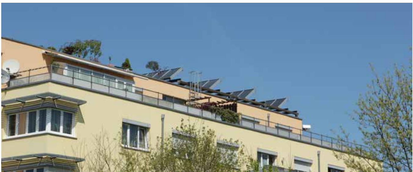
Dach mit Solaranlagen eines Mehrfamilienhauses / Aschaffenburg / Foto © planquadrat
