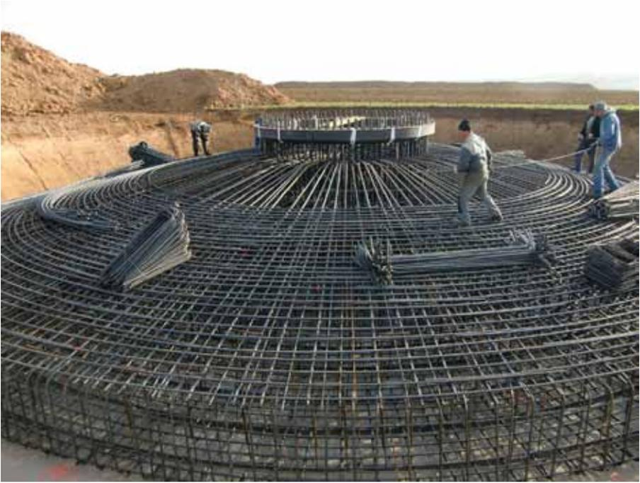
Armierungsarbeiten für das Stahlbetonfundament einer VESTAS V 90 am Standort Mainstockheim
