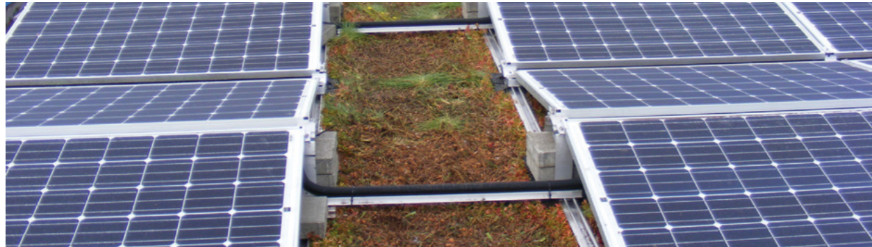
Klärwerk Aschaffenburg Spätherbst 2016: weniger Hitzestau durch Dachbegrünung führt zu mehr Leistung bei Photovoltaikanlagen
