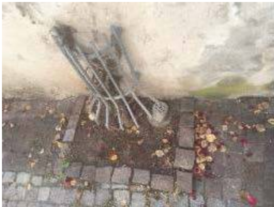
Abbildung 75: Gebäudefassade Aschaffenburg. Aufnahme: GreenAdapt 2020.
