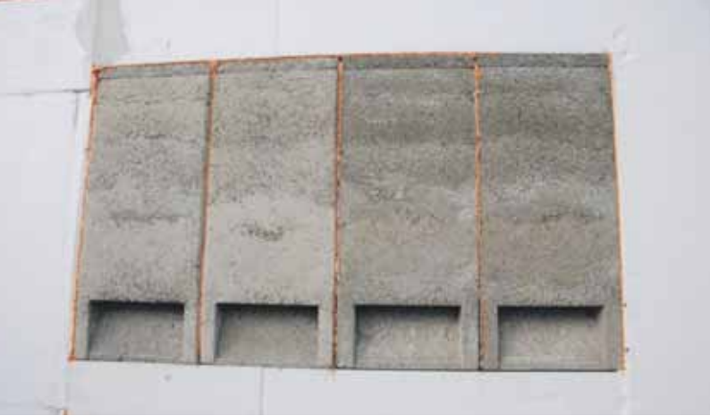
Fledermauskasten in der Wärmedämmung (Rohbau) © Sylvia Weber
