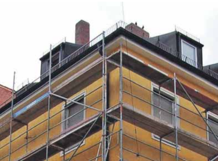
Anflug verhindert (links) und modifiziertes Gerüst (rechts)
