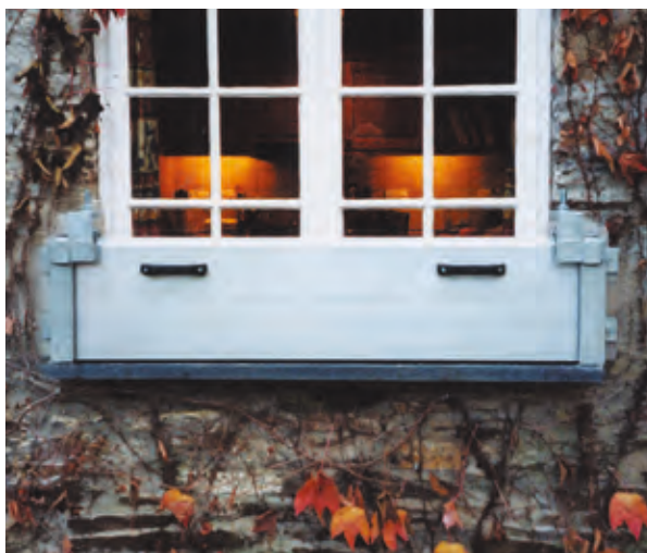
Hochwasserschutz an Fensteröffnungen
