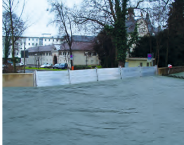
Mobiler Hochwasserschutz mit Dammbalken
