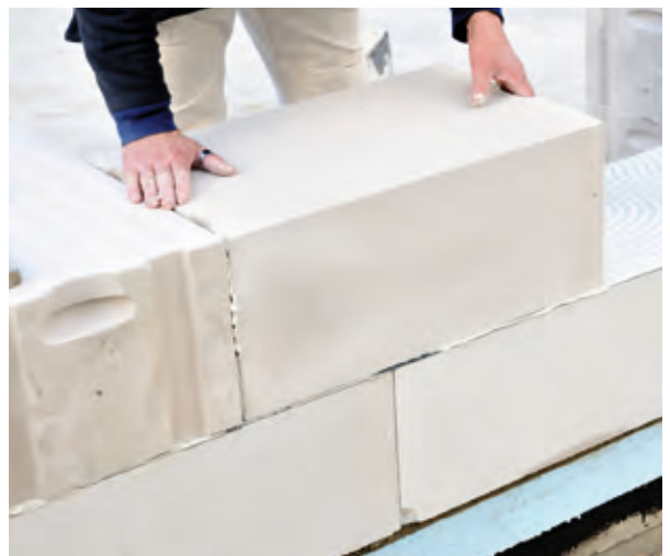
Mauerwerk aus Porenbeton
