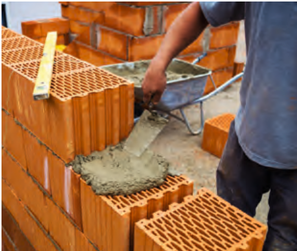
Mauerwerk aus Hochlochziegeln mit geringer Rohdichte
