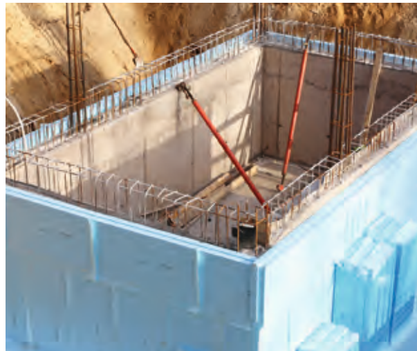
Keller in WU-Bauweise mit Wärmedämmschicht
