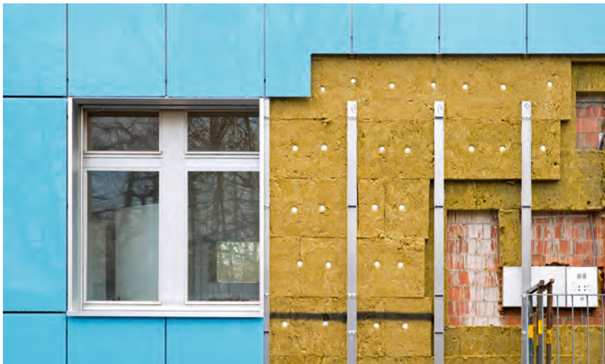
Hinterlüftete Fassadenkonstruktion
