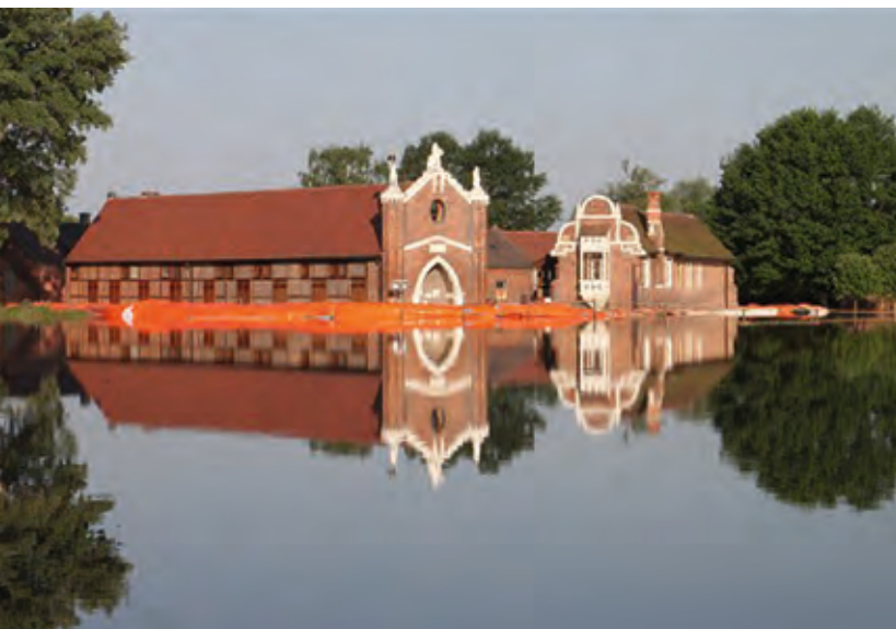
Hochwasserschutz mit mobilem wassergefülltem Schlauchsystem
