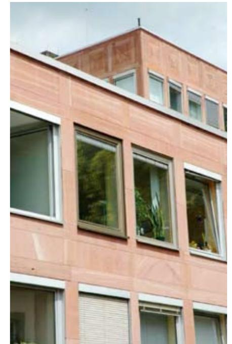
Abstimmung von Konstruktion und Denkmal: Die entwickelten Fensterkonstruktionen wurden mit dem Landesamt für Denkmalpflege abgestimmt. Nach Klärung der Detaillösungen wurden zwei Musterfenster unterschiedlicher Hersteller angefertigt, im Gebäude montiert und hinsichtlich ihrer Eignung überprüft.
