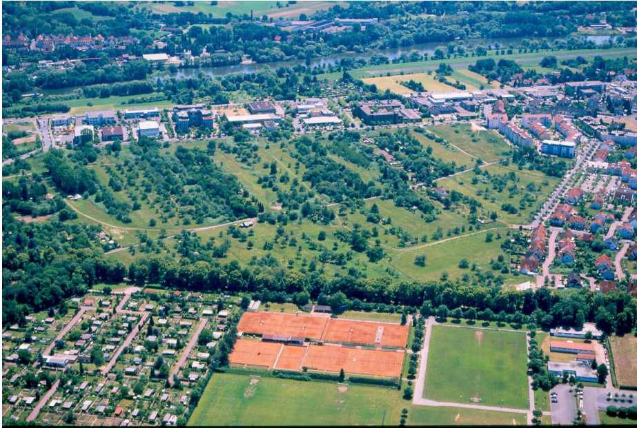
Abb.34: Das Plangebiet im Schrägluftbild aus nördlicher Richtung (Foto: Josef Diepold)
