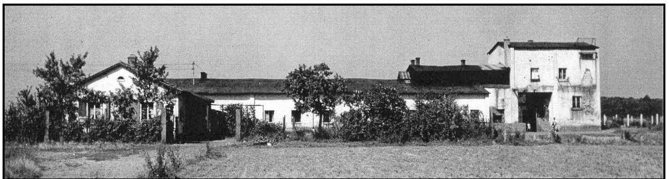
Abb.24: Das Schlackenwerk (von Süden fotografiert) Foto: Stadt- und Stiftsarchiv, Aschaffenburg
