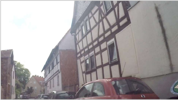
Gebäude aus der Baualtersklasse A.
