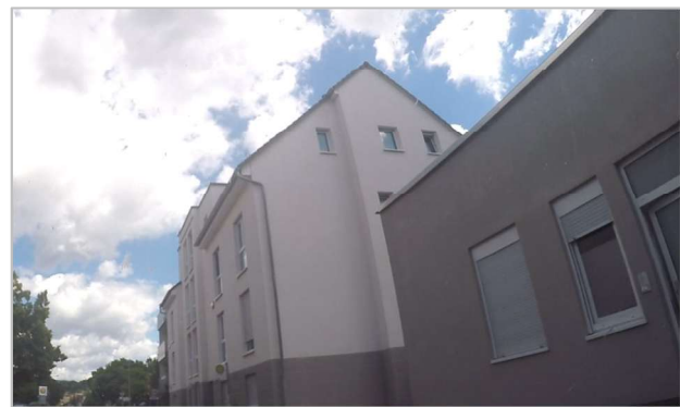
Gebäude aus der Baualtersklasse J und K.
