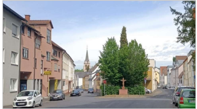
Gebäude aus der Baualtersklasse B bis E.
