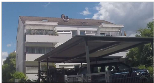
Gebäude aus der Baualtersklasse I.
