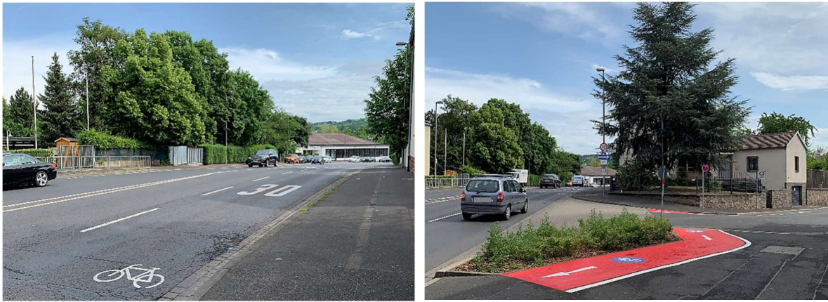
Abbildung 34: Beispiel für veraltete und neugestaltete Radverkehrsinfrastruktur entlang der Schillerstraße. Quelle: DSK GmbH 2022
