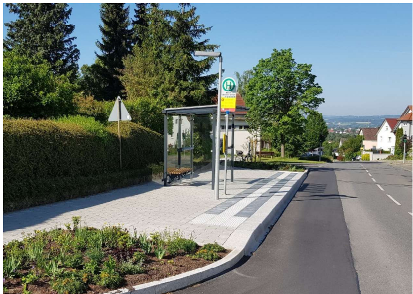
Beispiel einer barrierefreien Bushaltestelle in der Gemeinde Baidnt mit erhöhtem Bordstein, Leitstreifen und Sitzmöglichkeiten. Quelle: Gemeinde Baidnt 2020; baidnt.de/umwelt-verkehr/baumassnahmen/barrierefreien-bushaltestellen
