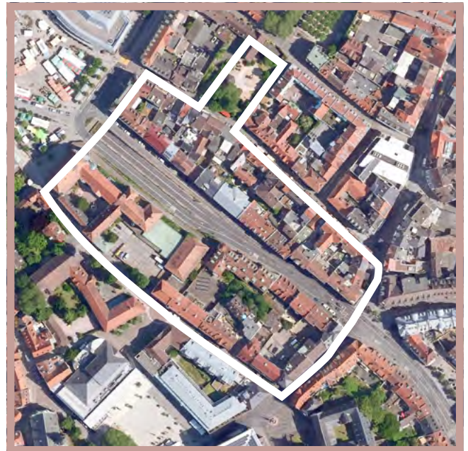
Sanierungs-Abschnitt 1 – Landingstraße, Steingasse, Pfaffengasse, Luftbild.
