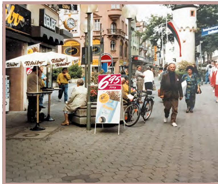
Betonverbundsteine in der Herstattstraße, 1990er-Jahre.
