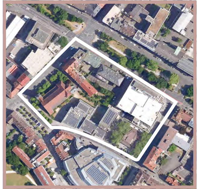
Sanierungs-Abschnitt 7 – Erthalstraße, Luftbild.
