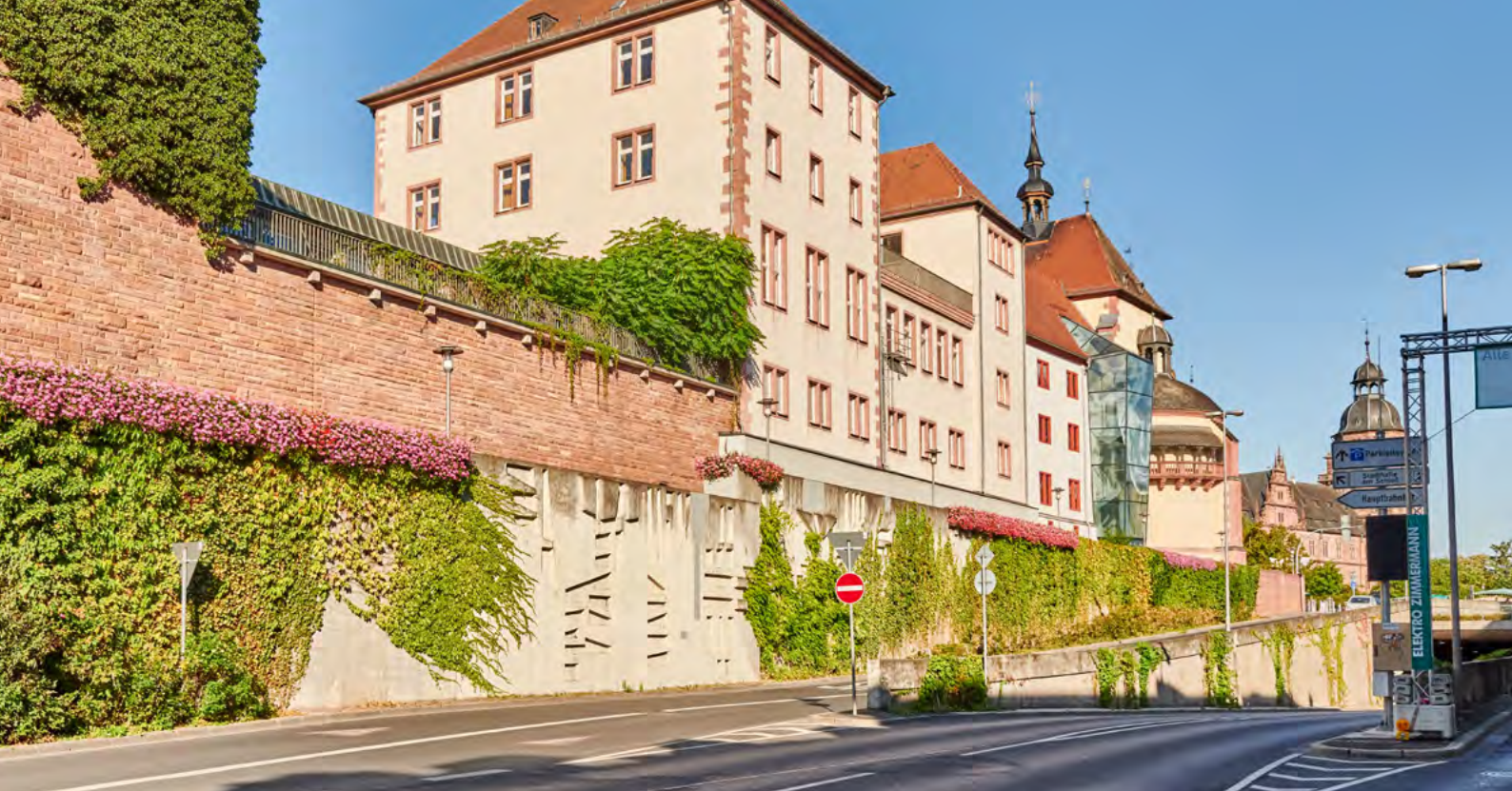
Oben: Landingstraße mit Stützmauer Tunneleingang.
