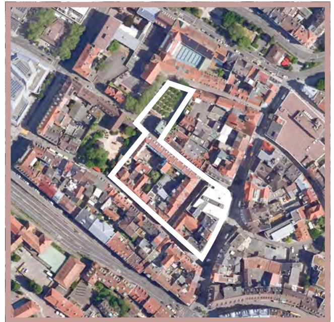
Sanierungs-Abschnitt 1a – alte Mälzerei, Luftbild.
