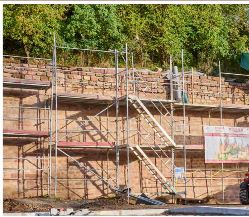
Oben: Schlossufer mit Schloss Johannisburg. Unten: Sanierung Stützmauer in der Suicardusstraße, Picknickwiese am Theoderichstor.
