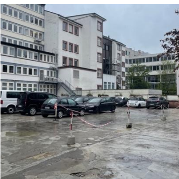
Abbildung 18 Versiegelter Parkplatz Glattbacher Überfahrt / Eisenstraße
