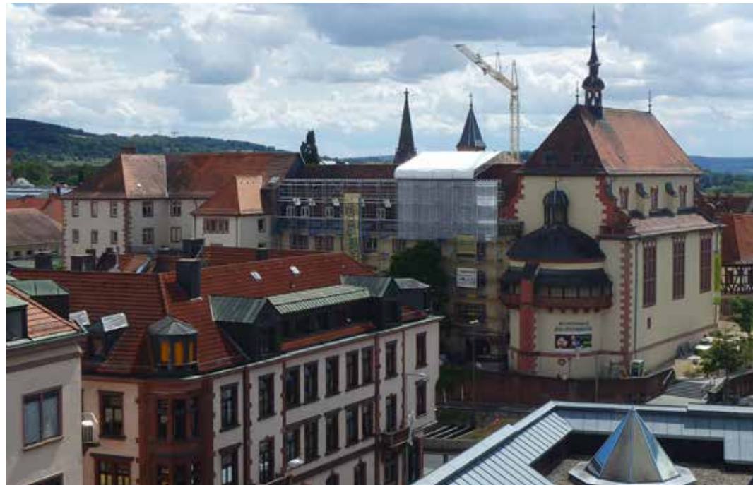
Der Gebäudekomplex während der Bauzeit
